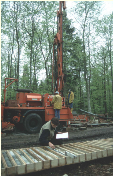
Abb. 1: Bohrung im Gelände
